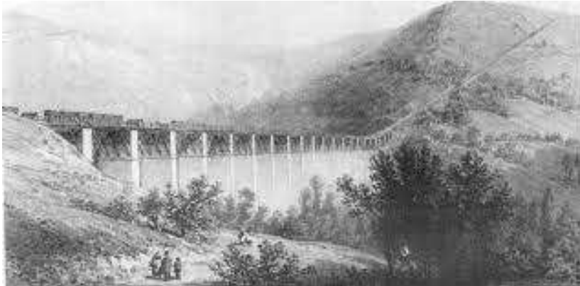
Gravure présentant le plan incliné de Marignon et le viaduc du Diénat en bois avant le comblement de la vallée par les déchets des mines
