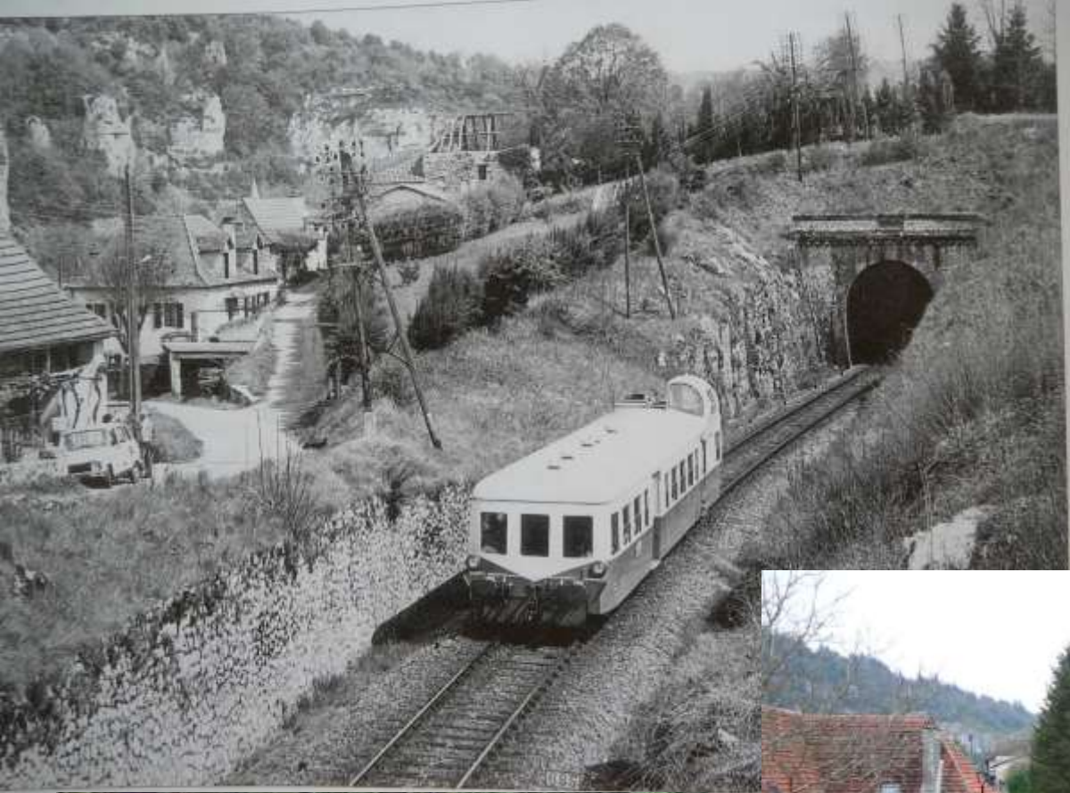
Deux vues de la sortie du tunnel de Bouziès . La photo ci-dessous date de mars 2015.
